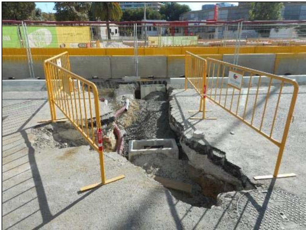
260. Cala final , cantonada carrer de la Independència.
