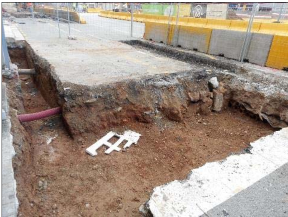
292. Obertura de rasa a la vorera de mar, cantonada nord amb el carrer Joan I.
