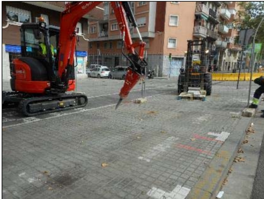
22. Màquina iniciant els treballs d'obertura de la Cala 3.
