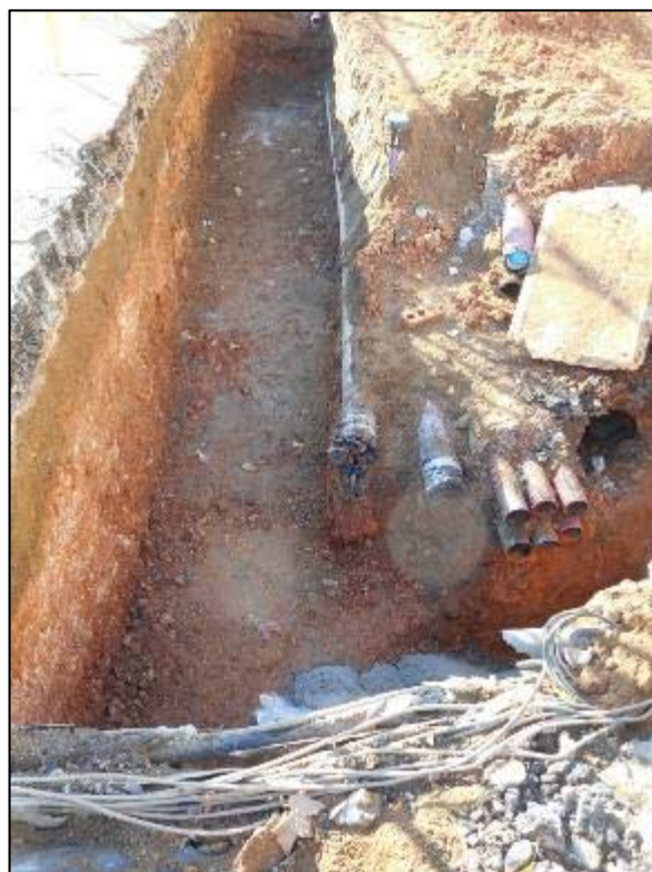
284. Obertura de rasa a la vorera de muntanya, cantonada amb carrer d'Aragó.
