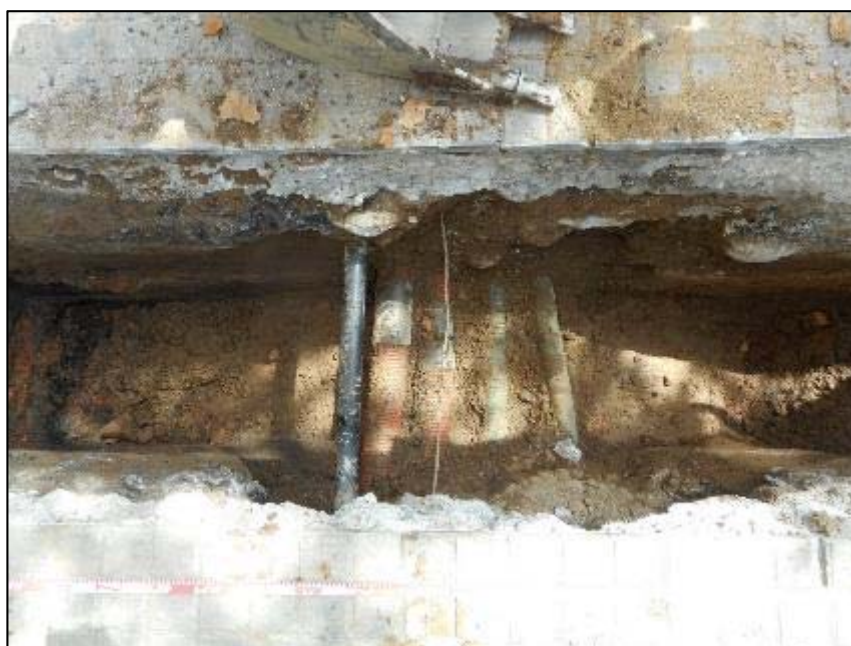
20. Cala 2, serveis UE 010 i col·lector UE 027.
