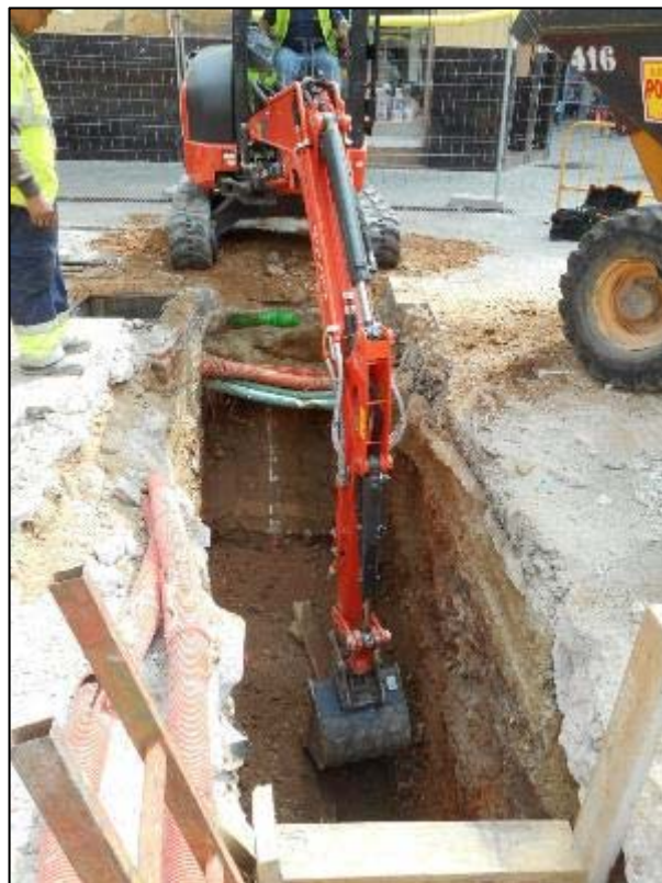
220. Obertura de rasa per connectar el col·lector a clavegueram existent.
