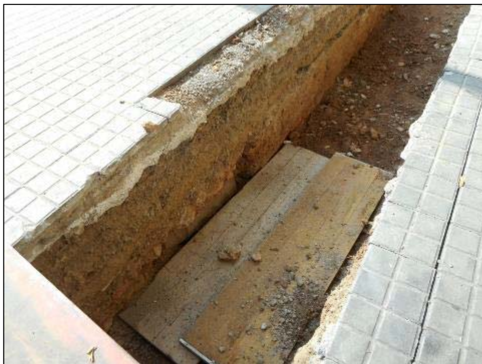
79. Rasa longitudinal, localització de l'antic embornal UE 034, cobriment provisional.
