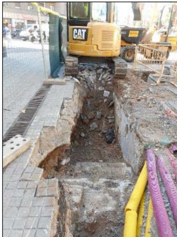
226. Obertura de la rasa a la zona de les escales UE 008 documentades durant les cales inicials.
