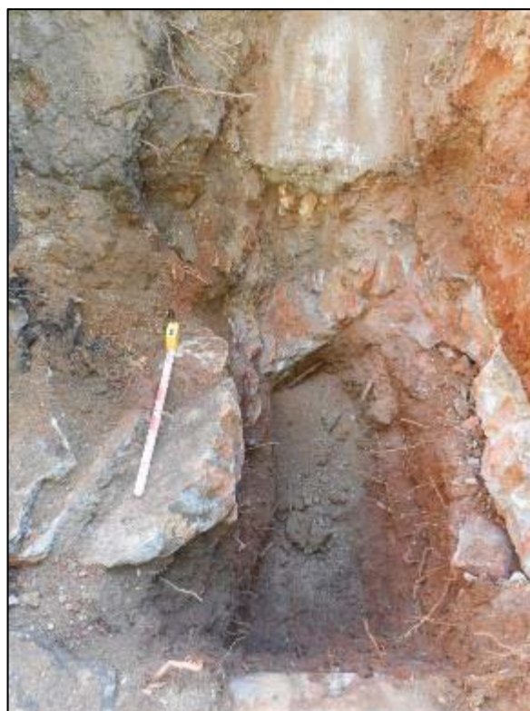
204.Cala 9, detall de obertura de l'estructura UE 040, Tram Sud del Rec Comtal.
