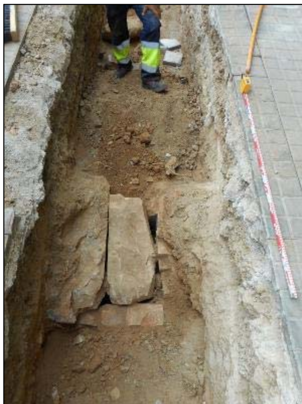
67. Rasa longitudinal, localització de l'antic embornal UE 034.
