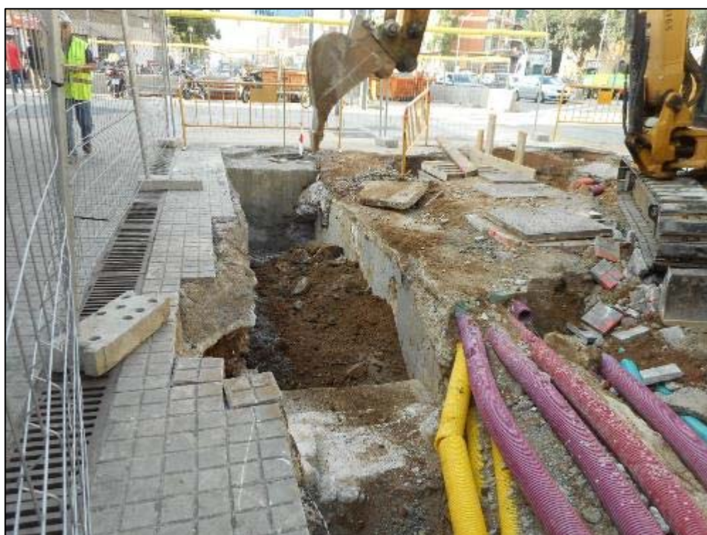
240. Màquina realitzant les tasques de reompliment de l'accés de l'antiga boca de metro documentada.
