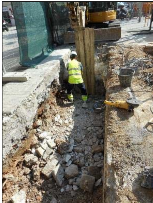
238. Màquina realitzant les tasques de reparació de la paret del prisma per a l'equipament de ventilació del metro actual.
