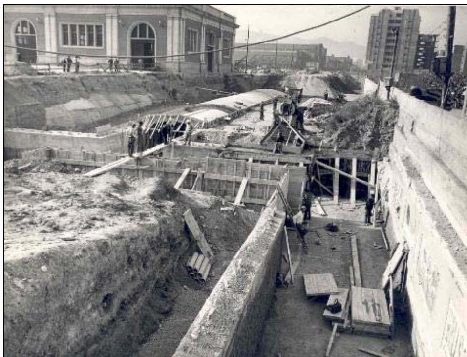
Obres de prolongació de la línia 1 de metro, 1965. Fons TMB.
