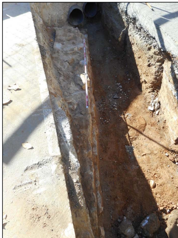
183.Prolongació del mur UE 012 al llarg de la rasa de muntanya.
