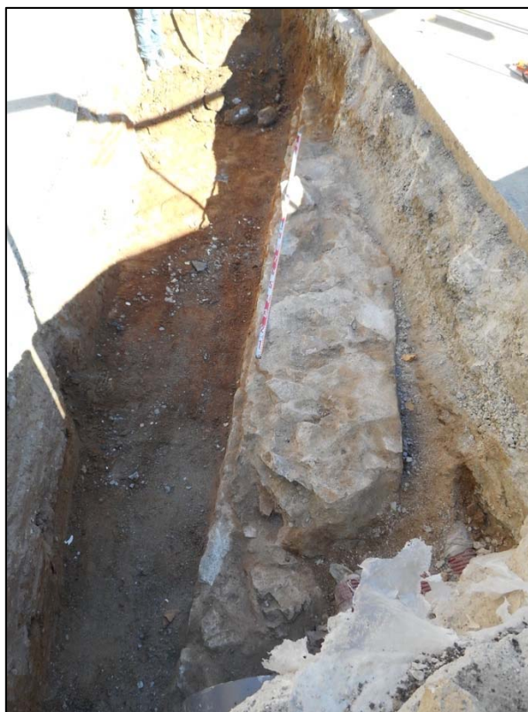
180. Prolongació del mur UE 012 al llarg de la rasa de muntanya.
