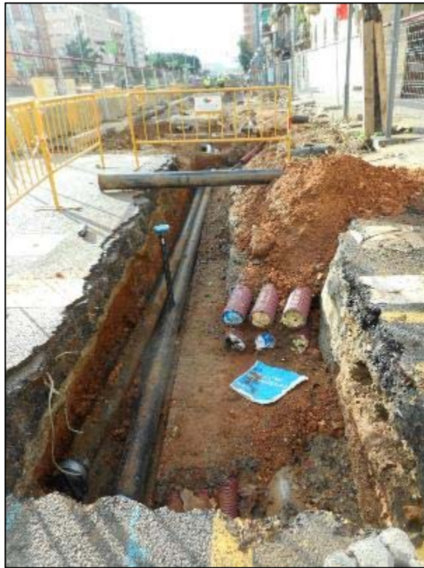
282. Obertura de rasa a la vorera de muntanya, cantonada carrer d'Aragó.
