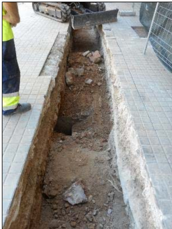
77. Rasa longitudinal, localització de l'antic embornal UE 034.
