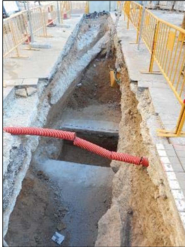
159. Vista general de l'estructura UE 011 amb el sondeig finalitzat..
