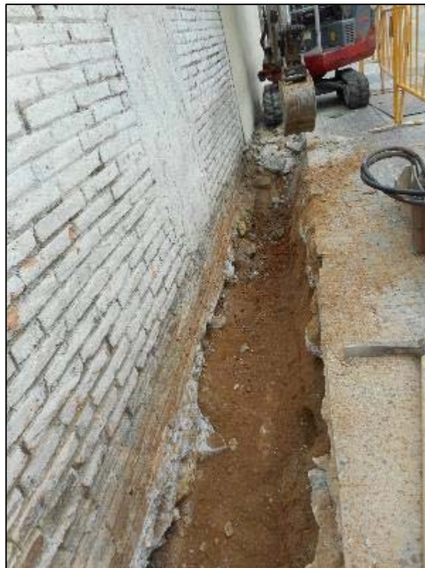
295. Rasa per a la instal·lació de servei d'aigua, en el tram entre els carrers d'Aragó i de València, vorera de mar.
