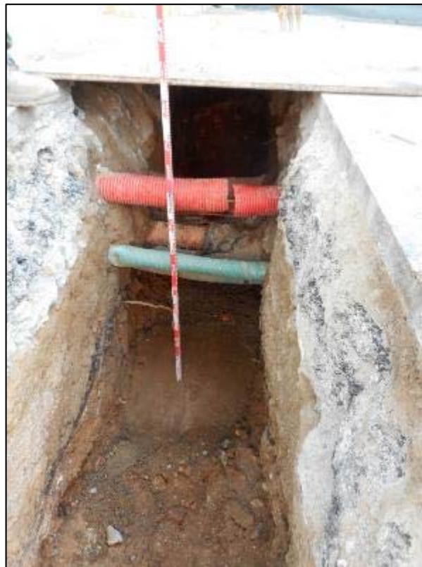
30. Presència d'un col·lector d'aigües residuals UE 027 a la Cala 3.
