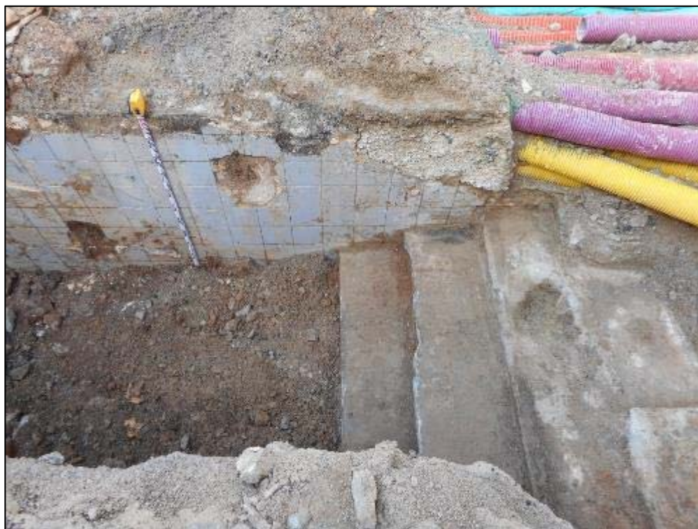
235. Detall del mur UE 009 i escales UE 008 documentades durant les cales inicials.
