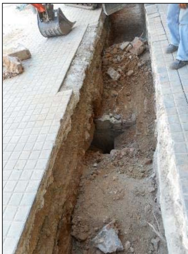
76. Rasa longitudinal, localització de l'antic embornal UE 034.
