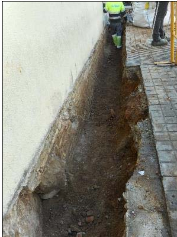
297. Rasa per a la instal·lació de servei d'aigua, en el tram entre els carrers d'Aragó i de València, vorera de mar.
