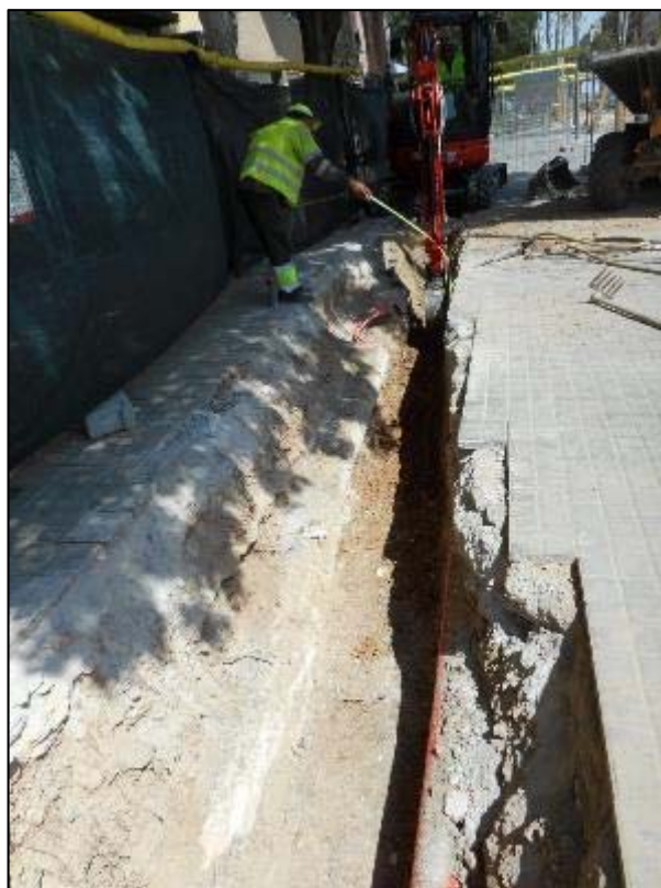
62. Rasa, màquina realitzant treballs.
