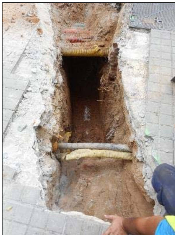
46. Cala 8, per a connexió amb el col·lector existent.
