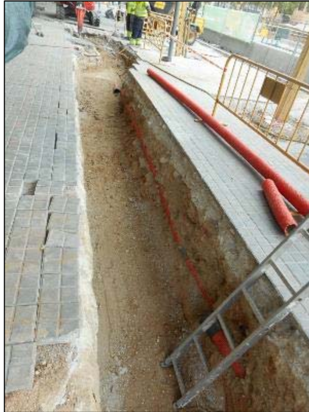
57. Perfil sud de la rasa longitudinal, presència de serveis.
