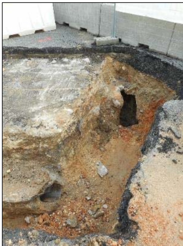
244. Localització de traçat de clavegueram antic a la cantonada amb el Carrer d'Aragó.
