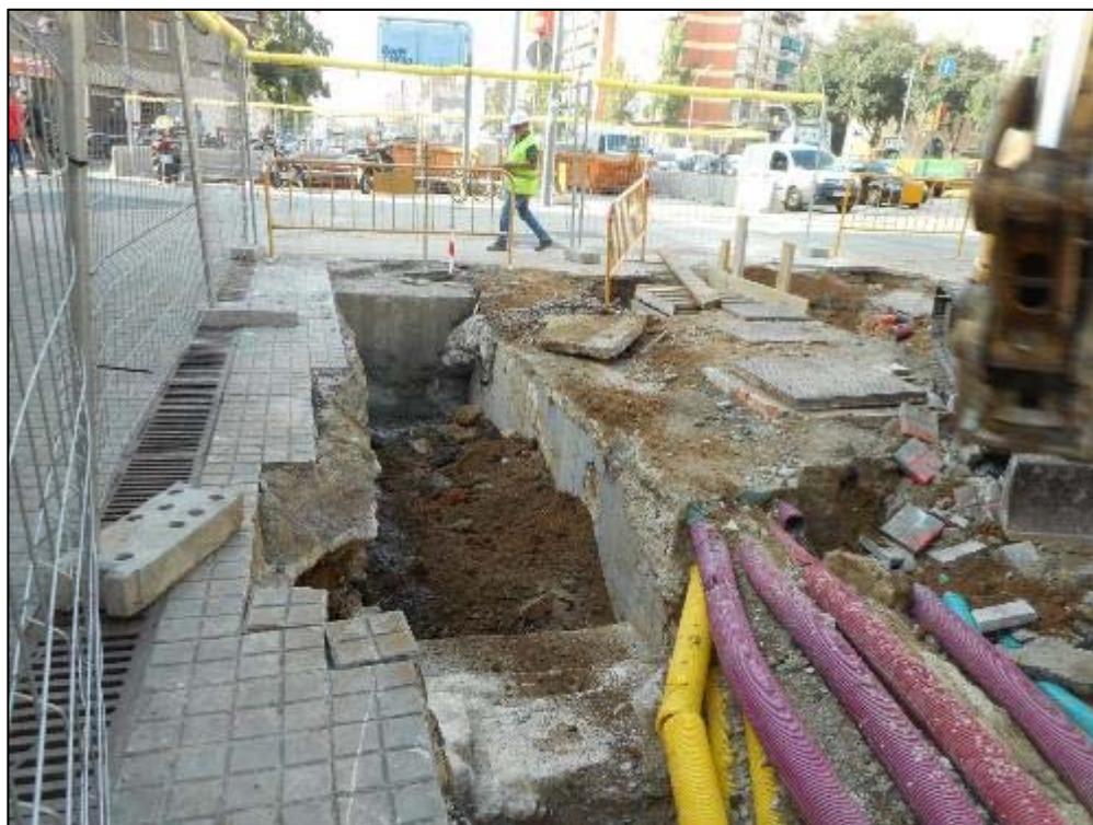
239. Espai de l'accés de l'antiga boca de metro, un cop realitzada la reparació de la paret del prisma per a l'equipament de ventilació del metro actual.
