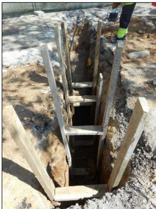
50. Rasa per a instal·lació de tub de connexió a clavegueram existent.
