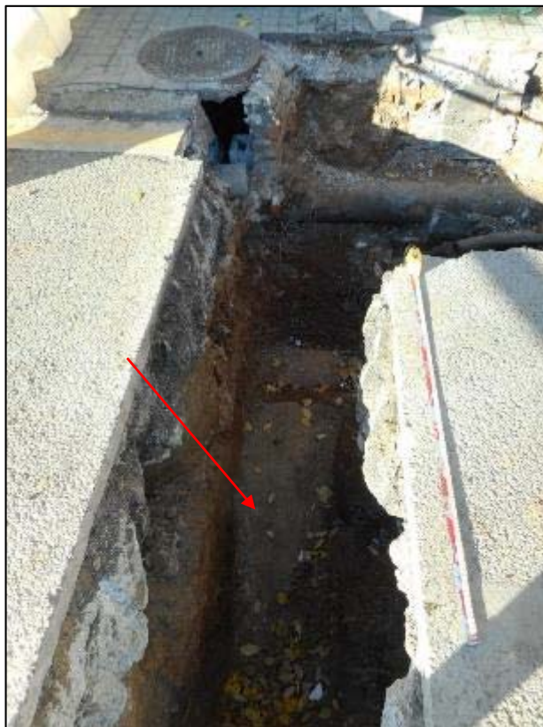
193.Cala 9, presència de la volta l'estructura UE 040, Tram Sud del Rec Comtal.
