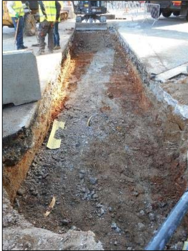
115. Obertura del tram que creua el carrer de València.
