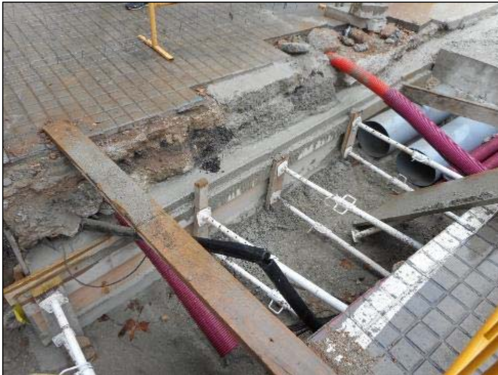
175.Construcció d'encofrat per a l'ompliment de la volta del Rec Comtal situada sota vorera per motius de seguretat.
