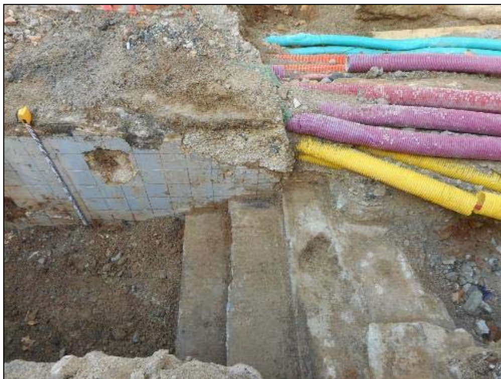
233. Detall del mur UE 009 i escales UE 008 documentades durant les cales inicials.
