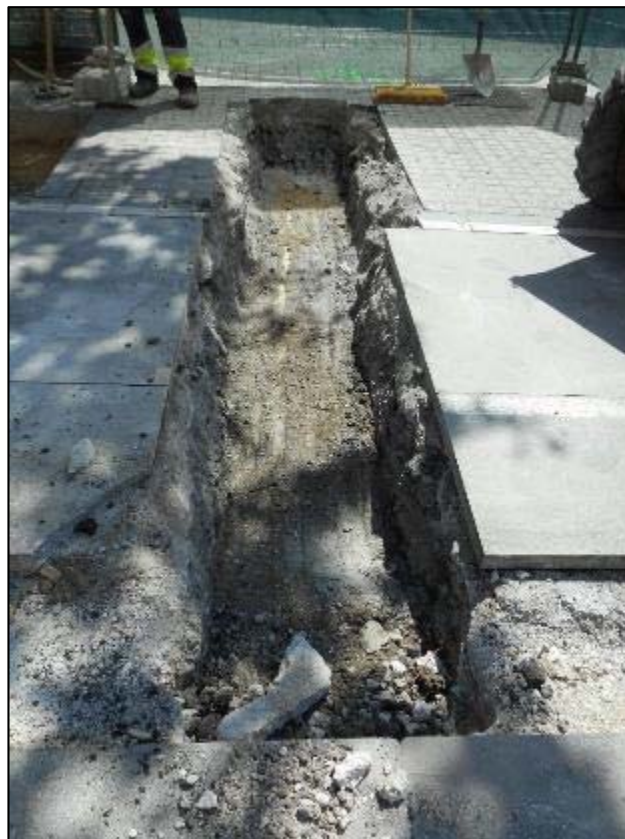
4. Nivell d'argiles un cop estreta la preparació de formigó, Cala 1.
