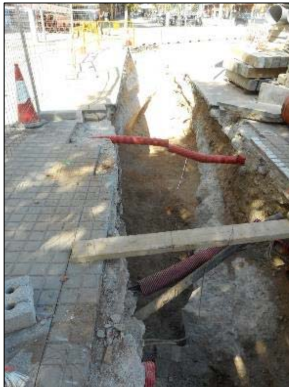
132. Excavació del terreny que oblitera l'estructura, inici/vista general.
