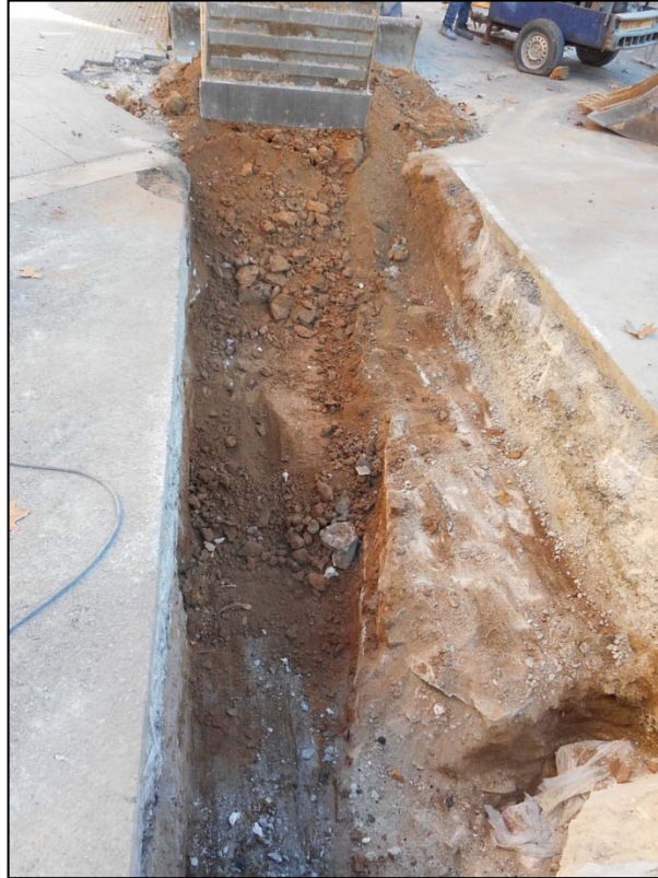
177.Prolongació del mur UE 012 al llarg de la rasa de muntanya.
