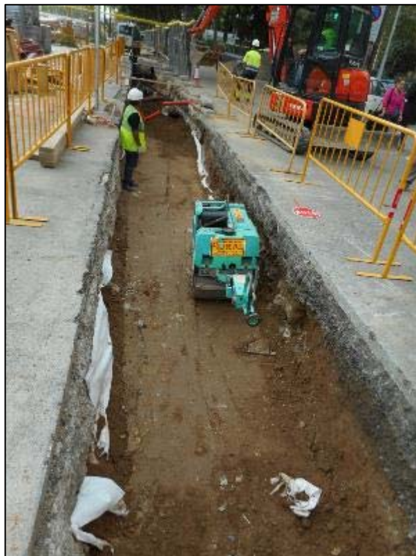
173. Compactació dels àrids abocats en el cobriment del tram localitzat del Rec Comtal i estructures properes.
