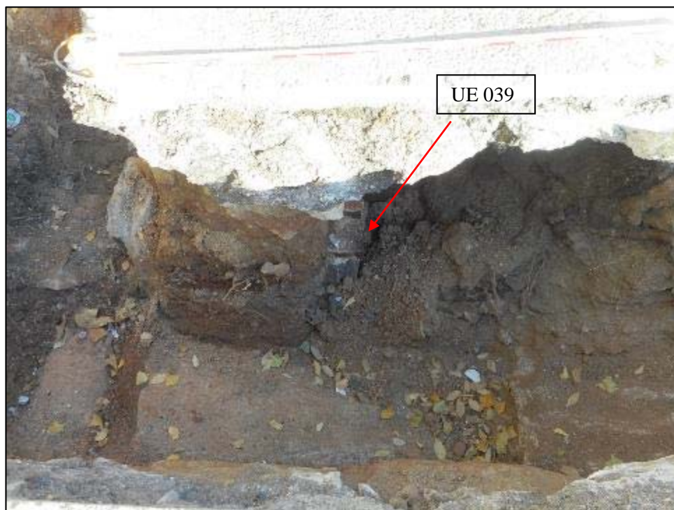
194.Cala 9, presència de l'estructura UE 040, afectada per diversos serveis, en primer terme arqueta UE 039 obrada en maons i formigó.
