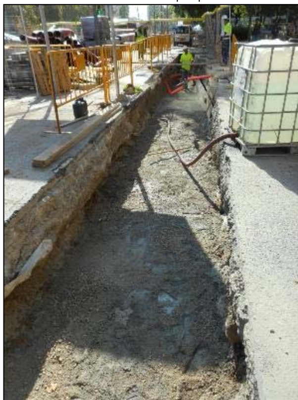
173. Compactació dels àrids abocats en el cobriment del tram localitzat del Rec Comtal i estructures properes.
