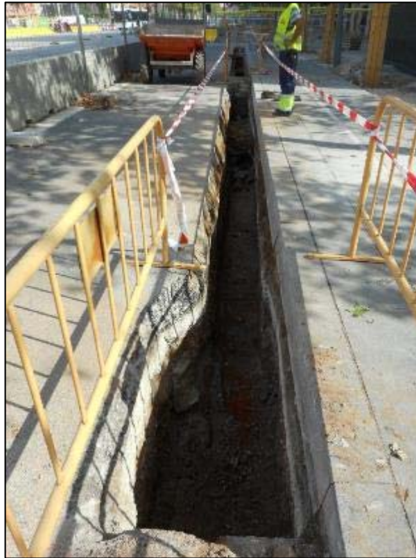
51. Rasa per a substitució del clavegueram anterior, instal·lació de nou servei.
