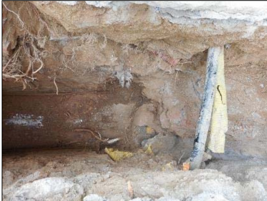
47. Cala 8, presència de diversos serveis, i tub de gas a 1 m de profunditat respecte la cota de vorera.
