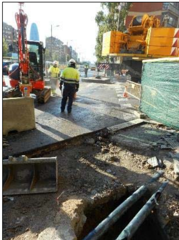
112. Obertura del tram que creua el carrer de València.
