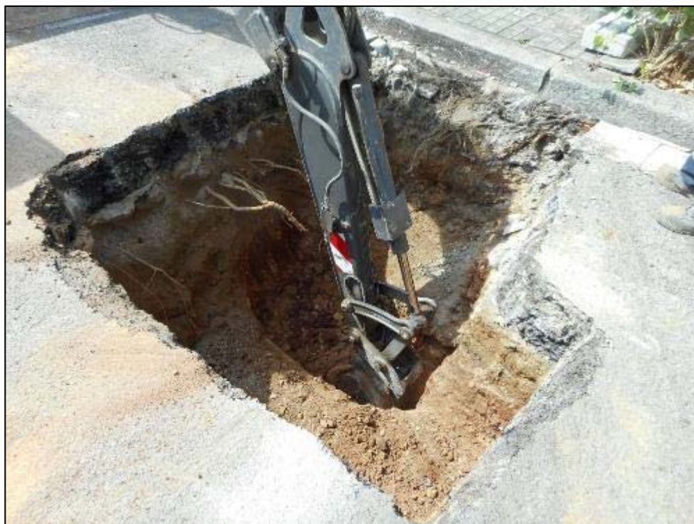
253. Màquina realitzant la Cala 1 cantonada del carrer d'Aragó, per a col·locar nous embornals.
