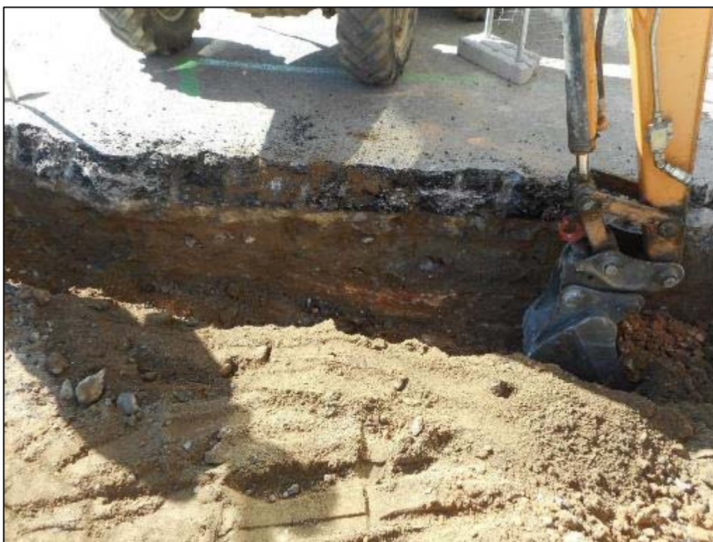
268. Màquina realitzant la rasa de connexió a la cala 5 en el tram entre els carrers del Consell de Cent i de la Independència.
