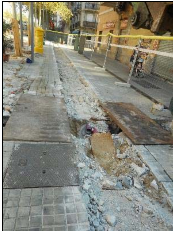
214. Rasa longitudinal, extracció de paviment de panot.
