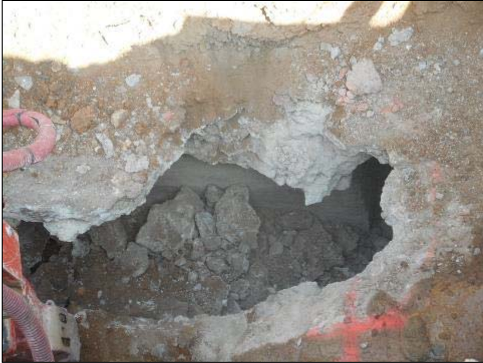
223. Obertura de ramal o escomesa antiga.
