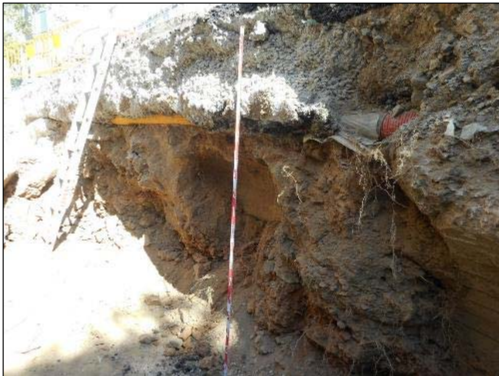
153. Detall de la secció Sud de la rasa, servei elèctric i clavegueram que afecten la volta de l'estructura UE 011.
