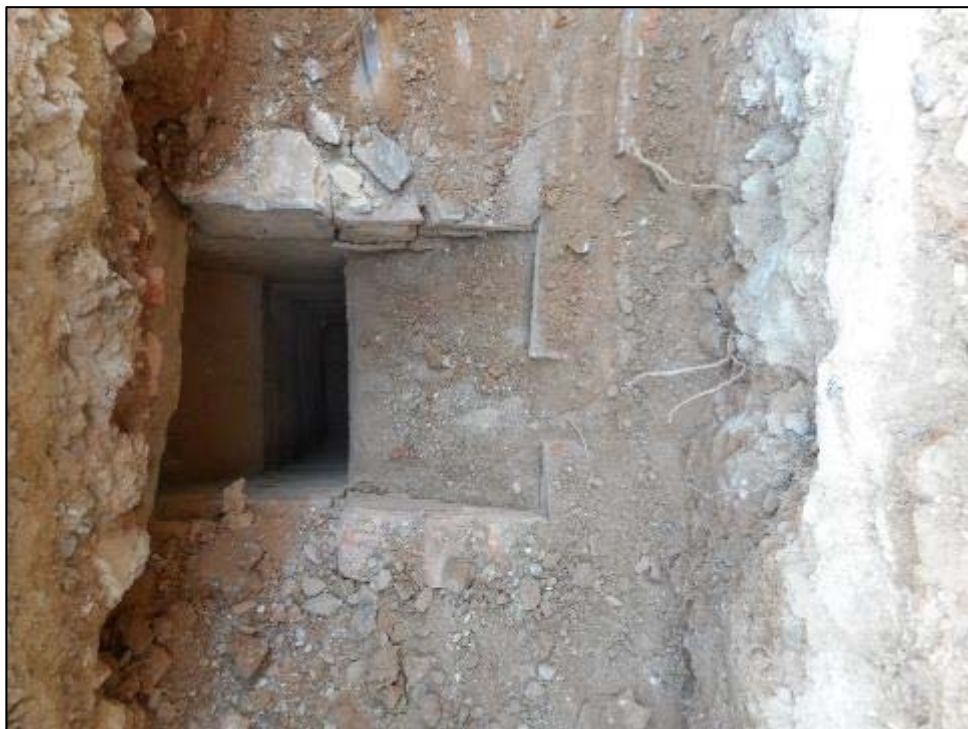
74. Rasa longitudinal, localització de l'antic embornal UE 034.
