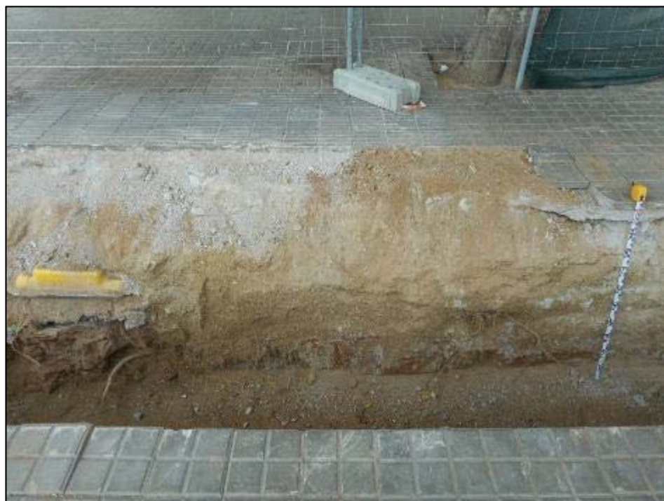
56. Secció del terreny de la rasa longitudinal.
