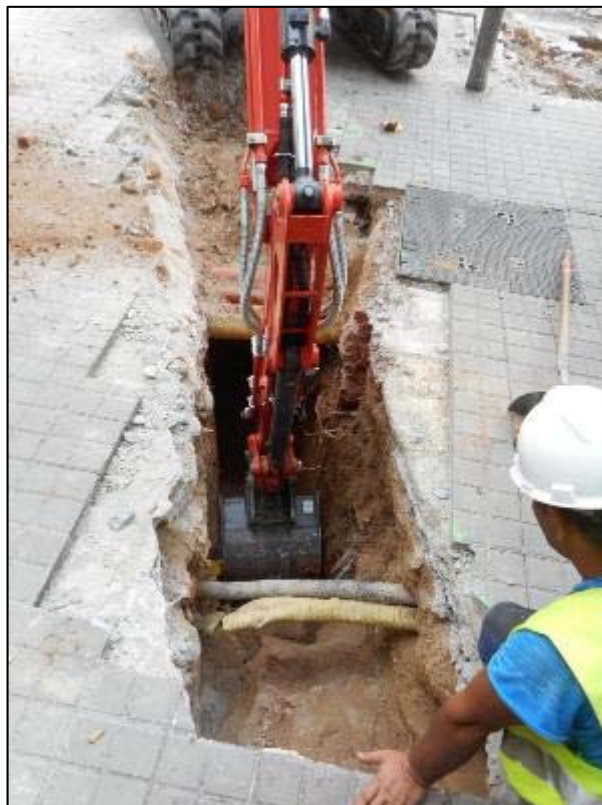
45. Cala 8, per a connexió amb el col·lector existent.
