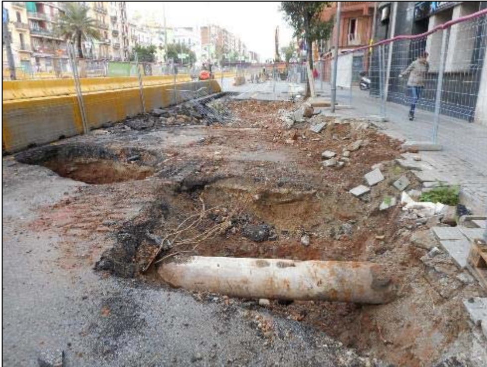
289. Obertura de rasa a la vorera de mar, cantonada amb carrer de Joan I.
