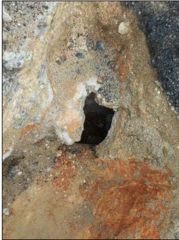
245. Localització de traçat de clavegueram antic a la cantonada amb el Carrer d'Aragó.
