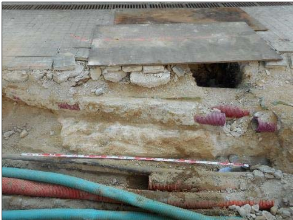
218. Rasa longitudinal, detall del mur UE 009 que funcionaria amb les escales UE 008 documentades a les cales inicials.
