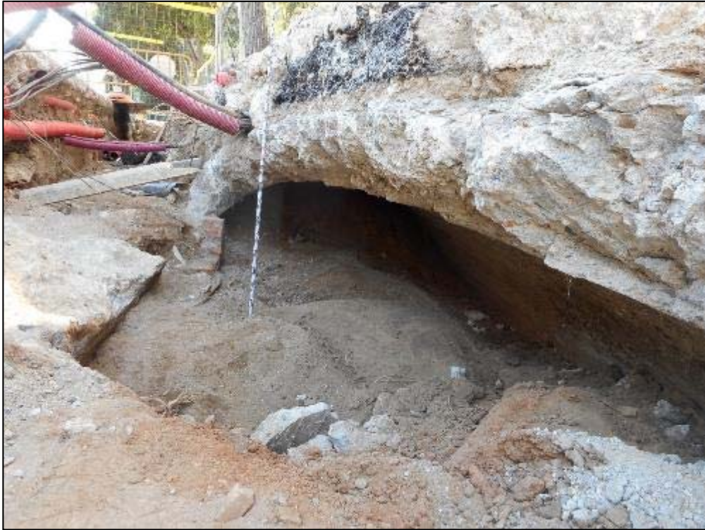
119. Volta de canó UE 011 pertanyent a la canalització del Rec comtal.
