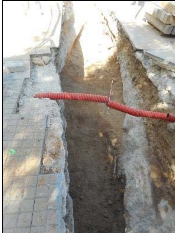
131. Excavació del terreny que oblitera l'estructura, inici/vista general.
