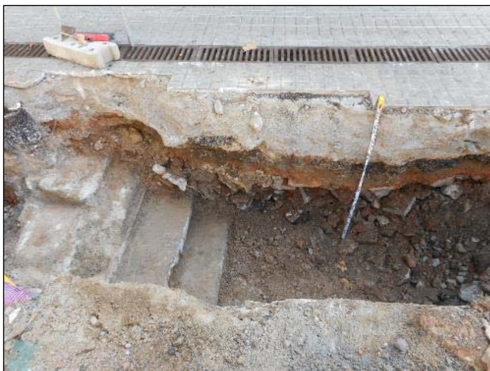
236. Detall de la secció sud de l'accés d'una antiga boca de metro, documentades durant les cales inicials.
