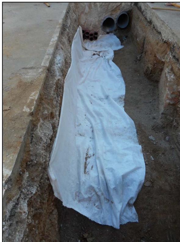
190. Cobriment de les restes de la prolongació del mur UE 012 un cop realitzat el desmuntatge fins a cota requerida.
