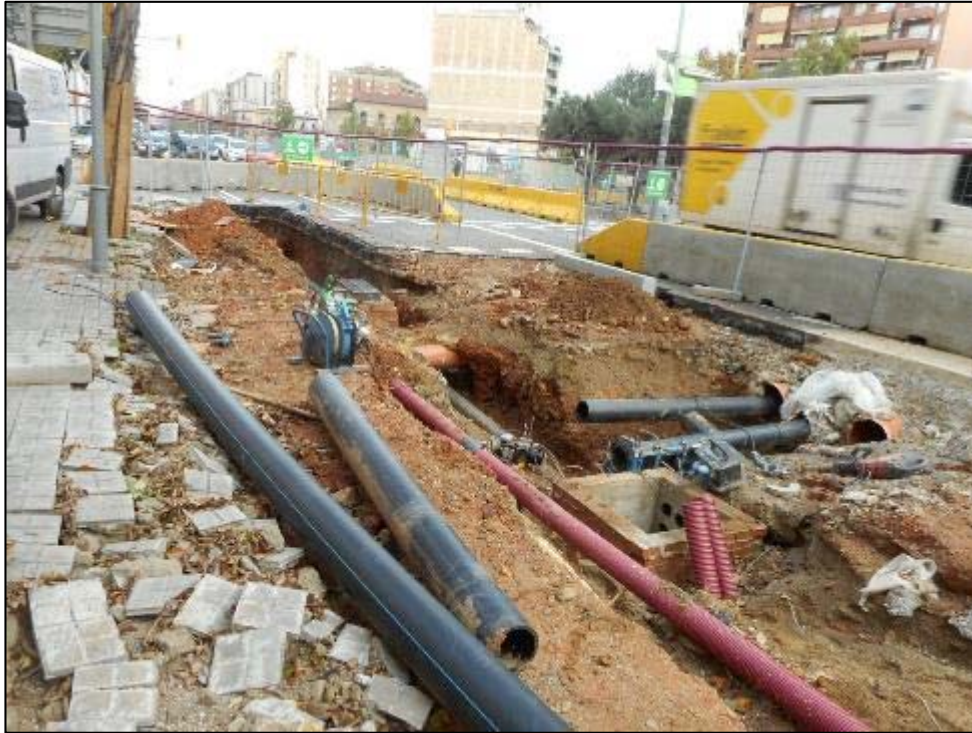
285. Obertura de rasa a la vorera de muntanya, cantonada amb carrer d'Aragó, direcció Nord.
