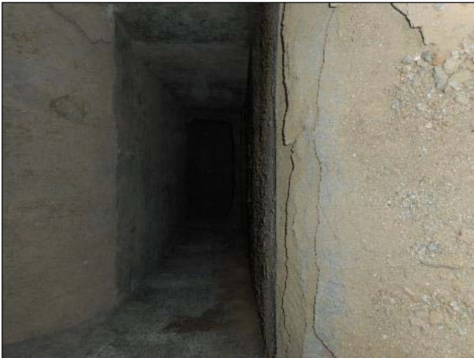
72. Rasa longitudinal, localització de l'antic embornal UE 034, vista de l'interior.
