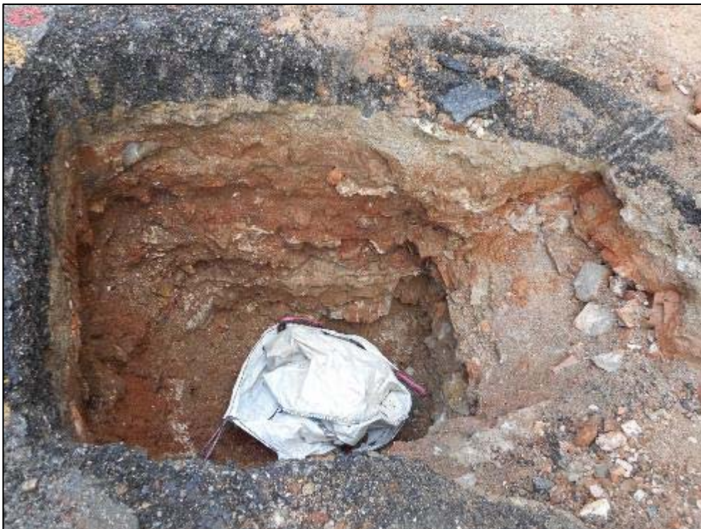
290. Obertura de rasa a la vorera de mar, cantonada amb carrer de Joan I.
