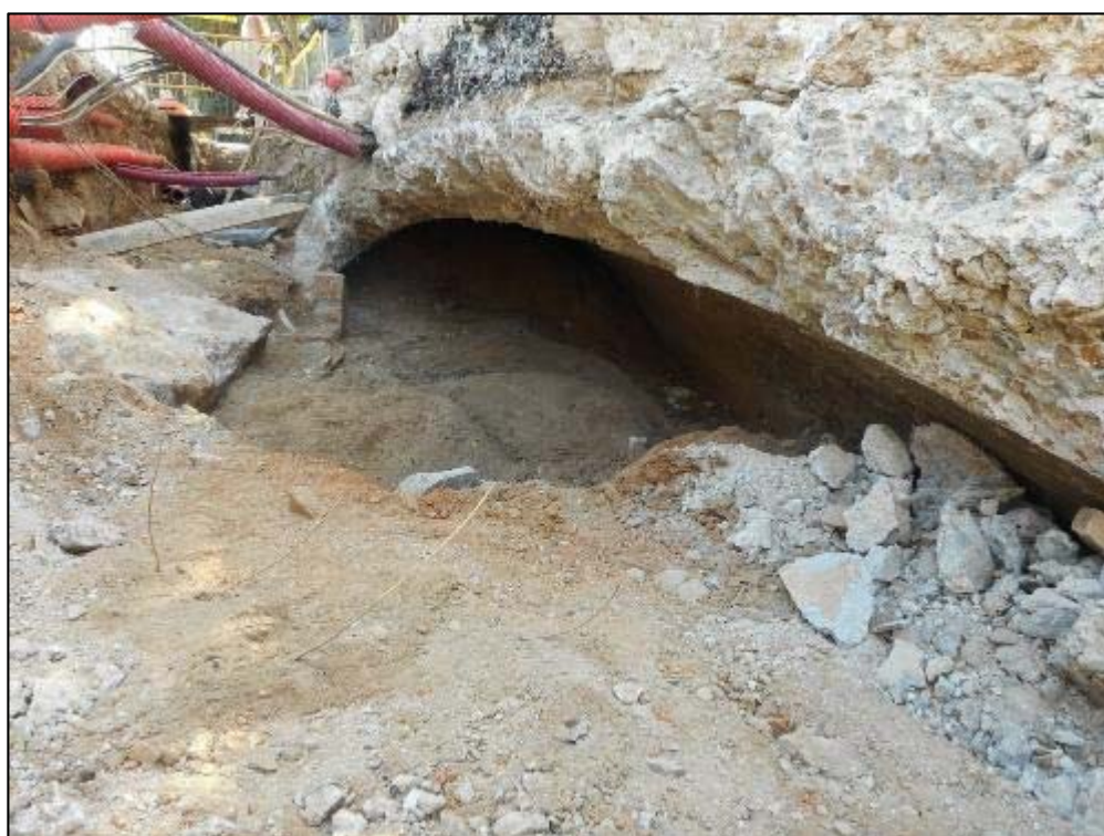
124. Vista exterior de la canalització del Rec Comtal.
