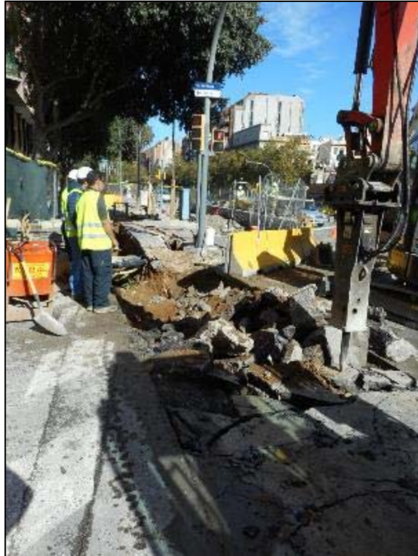
113. Obertura del tram que creua el carrer de València.
