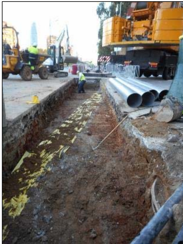
116. Obertura del tram que creua el carrer de València.
