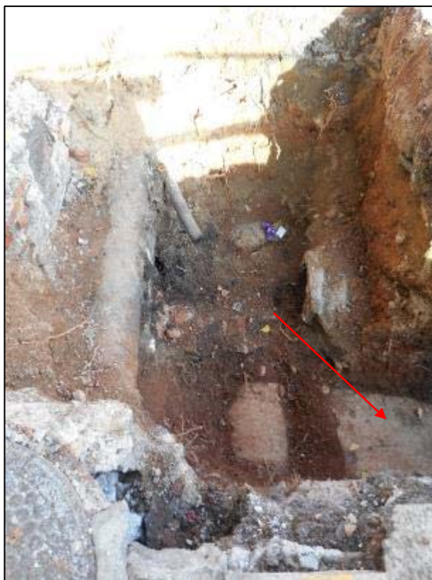
191. Cala 9, cantonada carrer de València presència de la volta de l'estructura UE 040, afectada per diversos serveis, Tram Sud del Rec Comtal.
