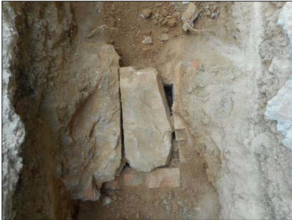
69. Rasa longitudinal, localització de l'antic embornal UE 034.
