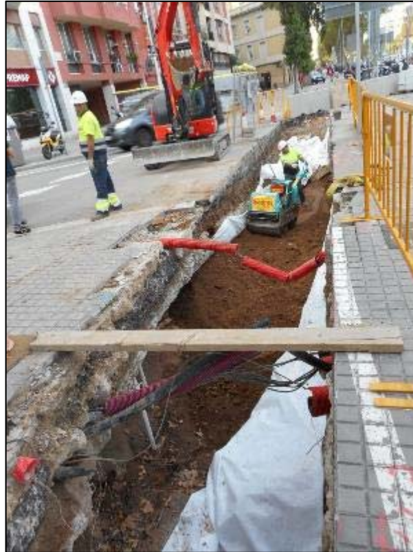
171. Compactació dels àrids abocats en el cobriment del tram localitzat del Rec Comtal i estructures properes.
