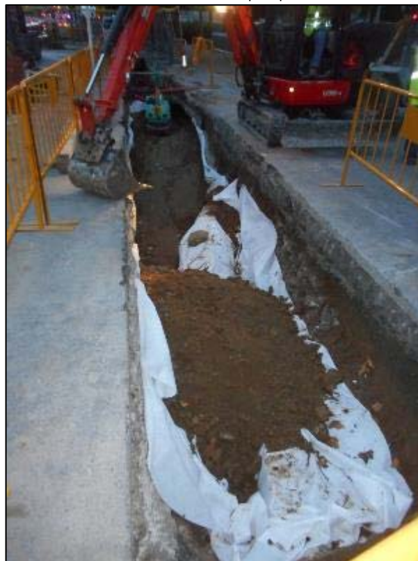
171. Compactació dels àrids abocats en el cobriment del tram localitzat del Rec Comtal i estructures properes.
