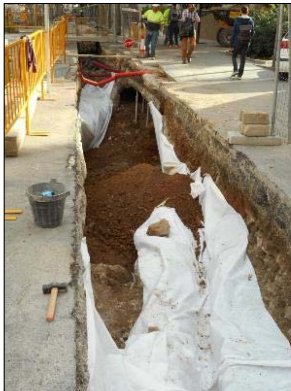
170.Cobriment amb àrids del tram localitzat del Rec Comtal i estructures properes.
