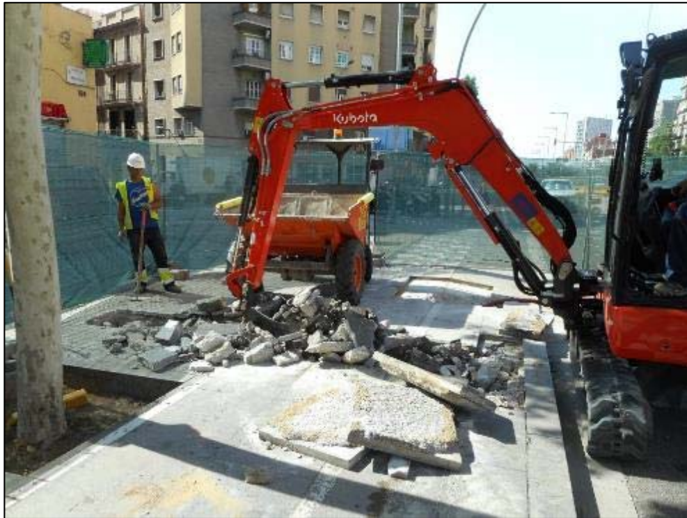
3. Màquina realitzant obertura de la Cala 1.
