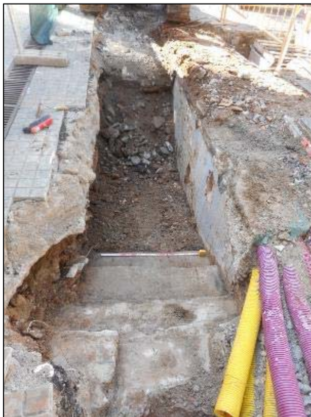
Vista general de l'accés a una boca de metro antiga, situada al carrer de València amb l'avinguda Meridiana, localitzat inicialment la Cala 1.
