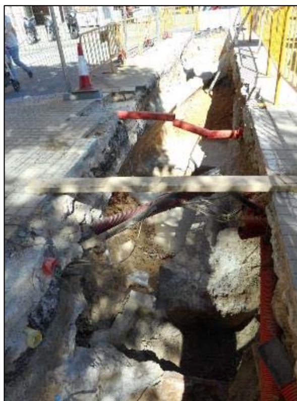
164. Vista general de l'estructura de canalització del Rec Comtal UE 011, un cop finalitzades les actuacions d'excavació arqueològica arrel de les mesures correctores aplicades.
