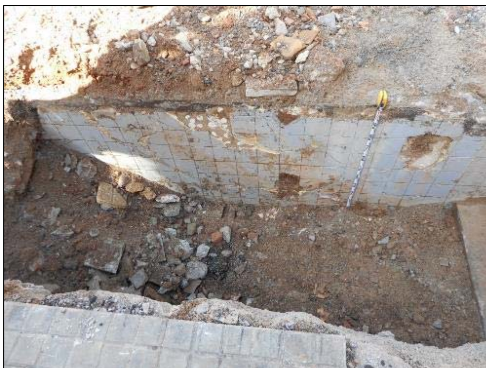
234. Detall interior enrajolat del mur nord UE 009 de l'accés soterrat d'una antiga boca de metro.
