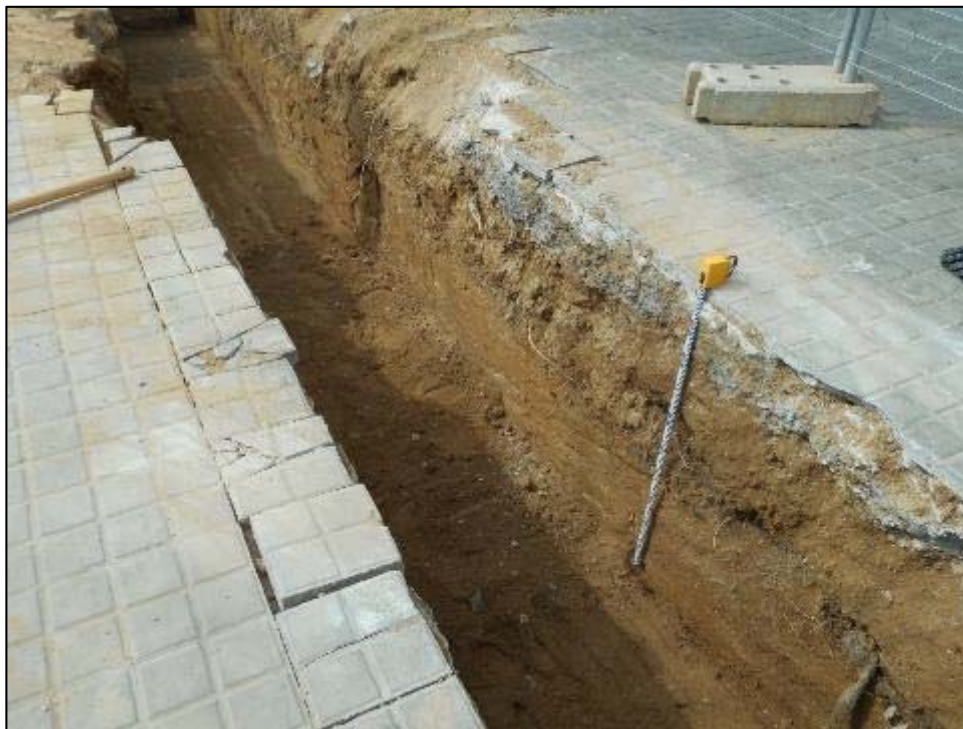
85. Rasa longitudinal, secció estratigràfica, perfil nord.
