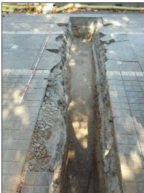
32. Cala 4, presència de la coberta del túnel d'ADIF UE 029.
