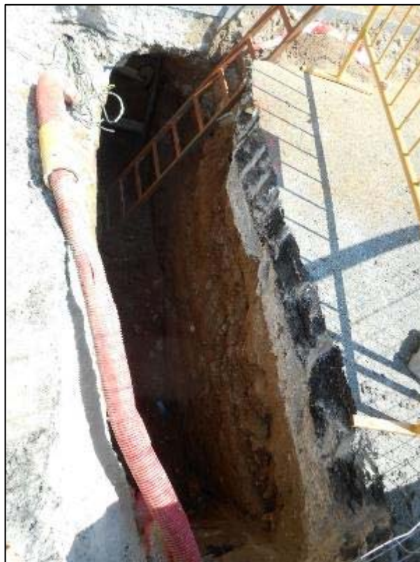
49. Rasa per a instal·lació de tub de connexió a clavegueram existent.
