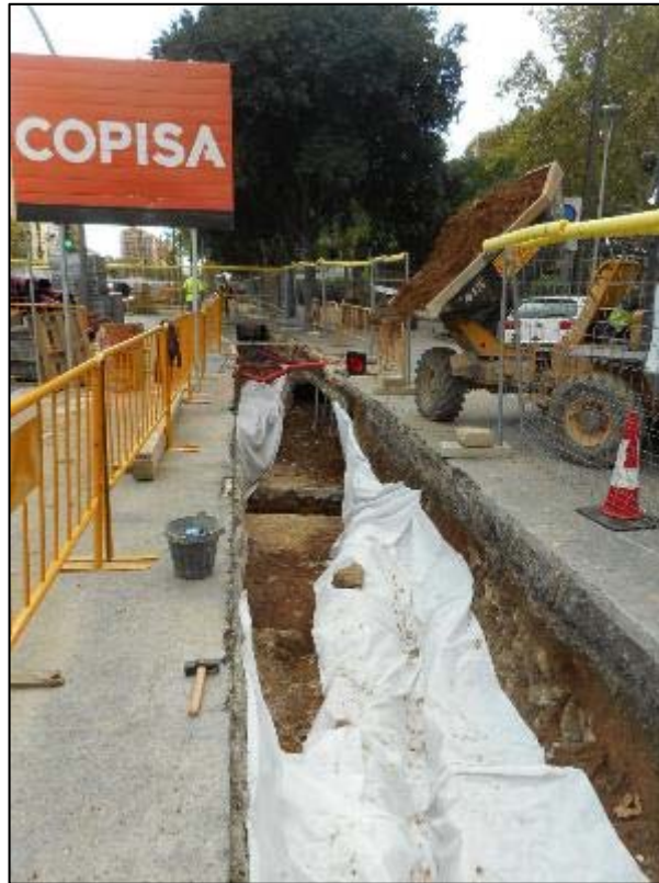
169.Cobriment amb geotèxtil del tram localitzat del Rec Comtal i estructures properes.
