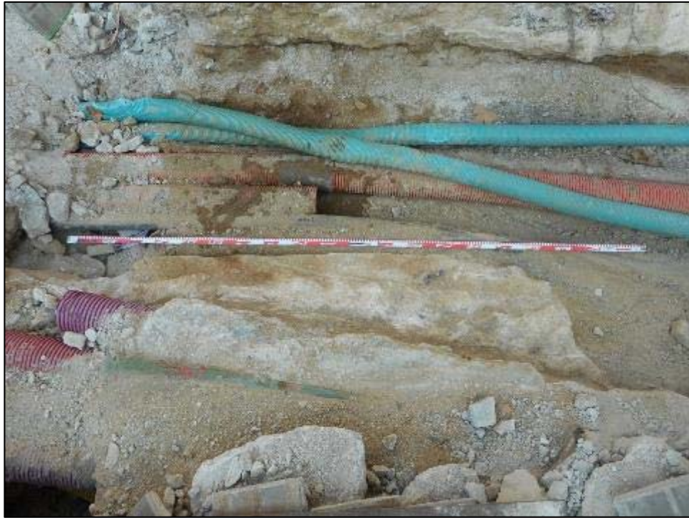
217. Rasa longitudinal, detall del mur UE 009 que funcionaria amb les escales UE 008 documentades a les cales inicials.
