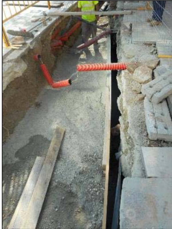
175.Construcció d'encofrat per a l'ompliment de la volta del Rec Comtal situada sota vorera per motius de seguretat.
