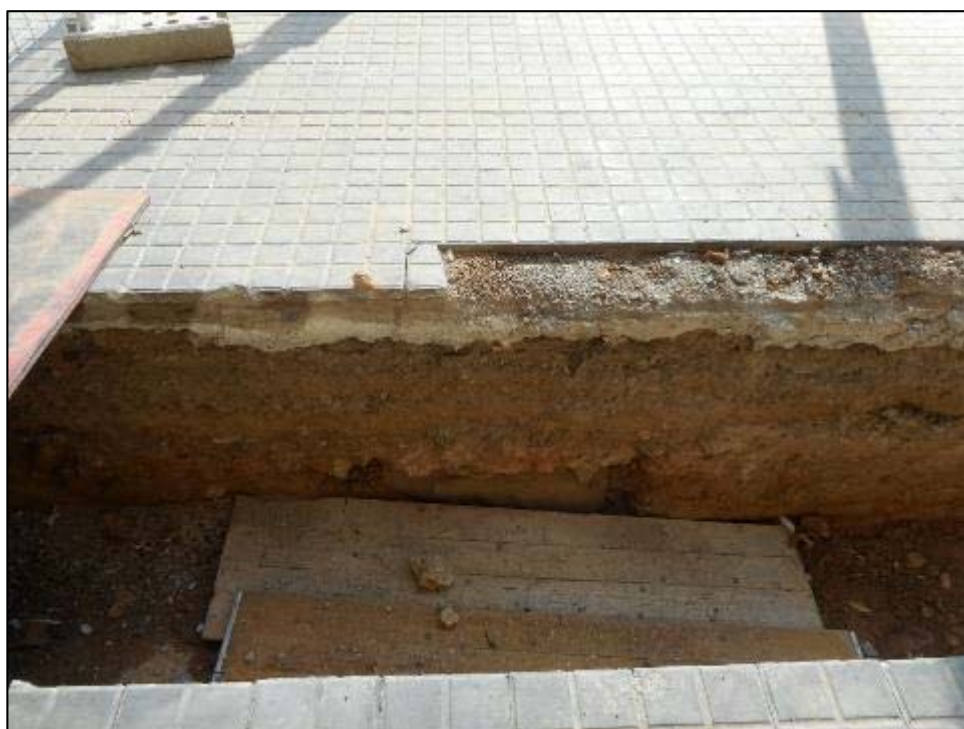
78. Rasa longitudinal, localització de l'antic embornal UE 034, cobriment provisional.
