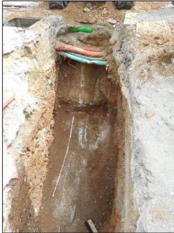
221. Sostre del col·lector UE 027 existent.
