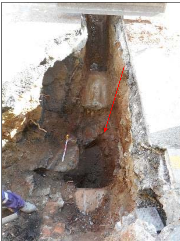
205.Cala 9, obertura de l'estructura UE 040, Tram Sud del Rec Comtal.
