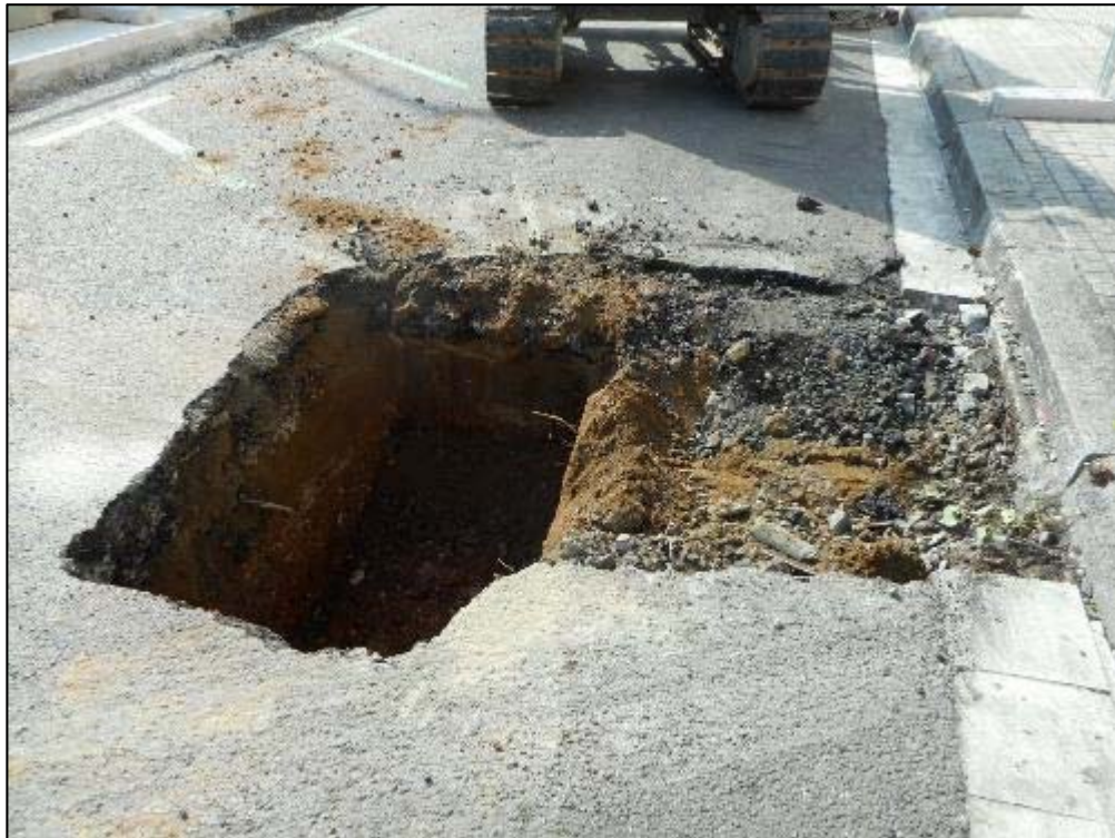
252. Cala 1 en el tram cantonada amb el carrer d'Aragó, per a col·locar nous embornals.
