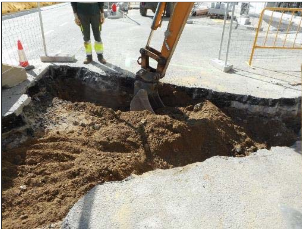
267. Màquina realitzant la rasa de connexió a la cala 5 en el tram entre els carrers del Consell de Cent i de la Independència.
