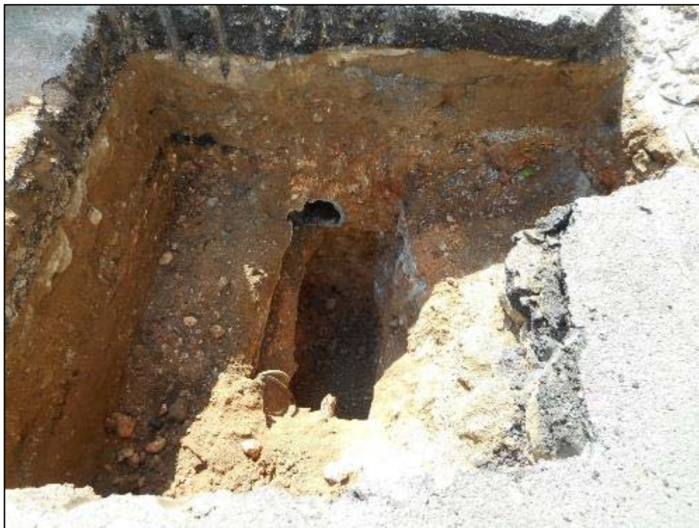
255. Cala 8 finalitzada, desmuntatge de servei en desús de fibrociment.
