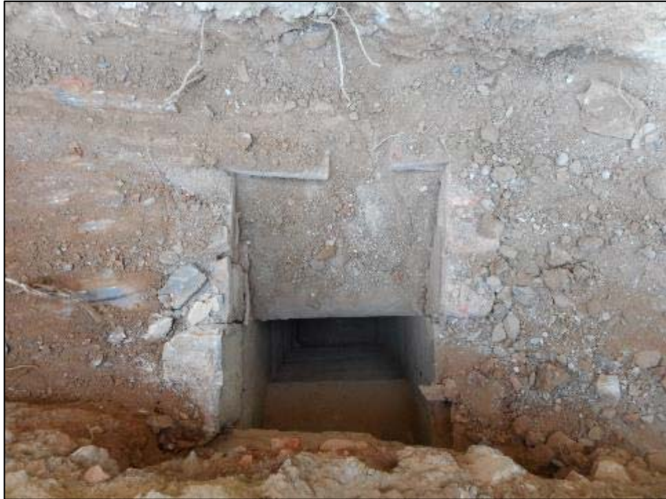
73. Rasa longitudinal, localització de l'antic embornal UE 034.
