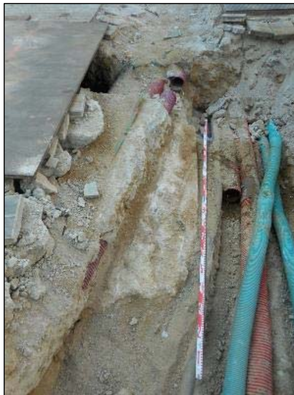
216. Rasa longitudinal, detall del mur UE 009 que funcionaria amb les escales UE 008 documentades a les cales inicials.
