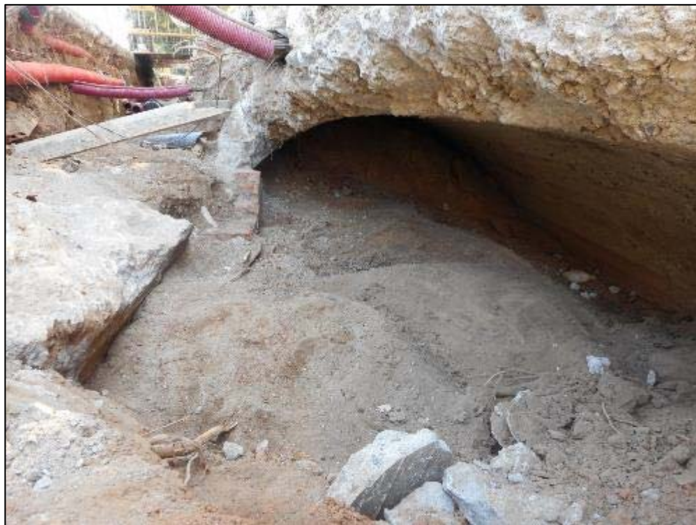
123. Interior de la canalització del Rec Comtal.
