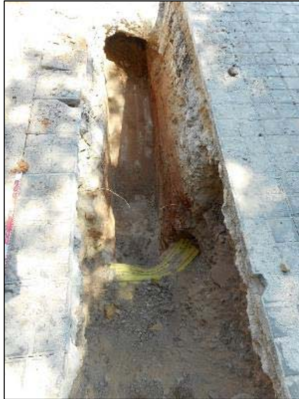
39. Cala 7, coberta del túnel d'ADIF UE 029.
