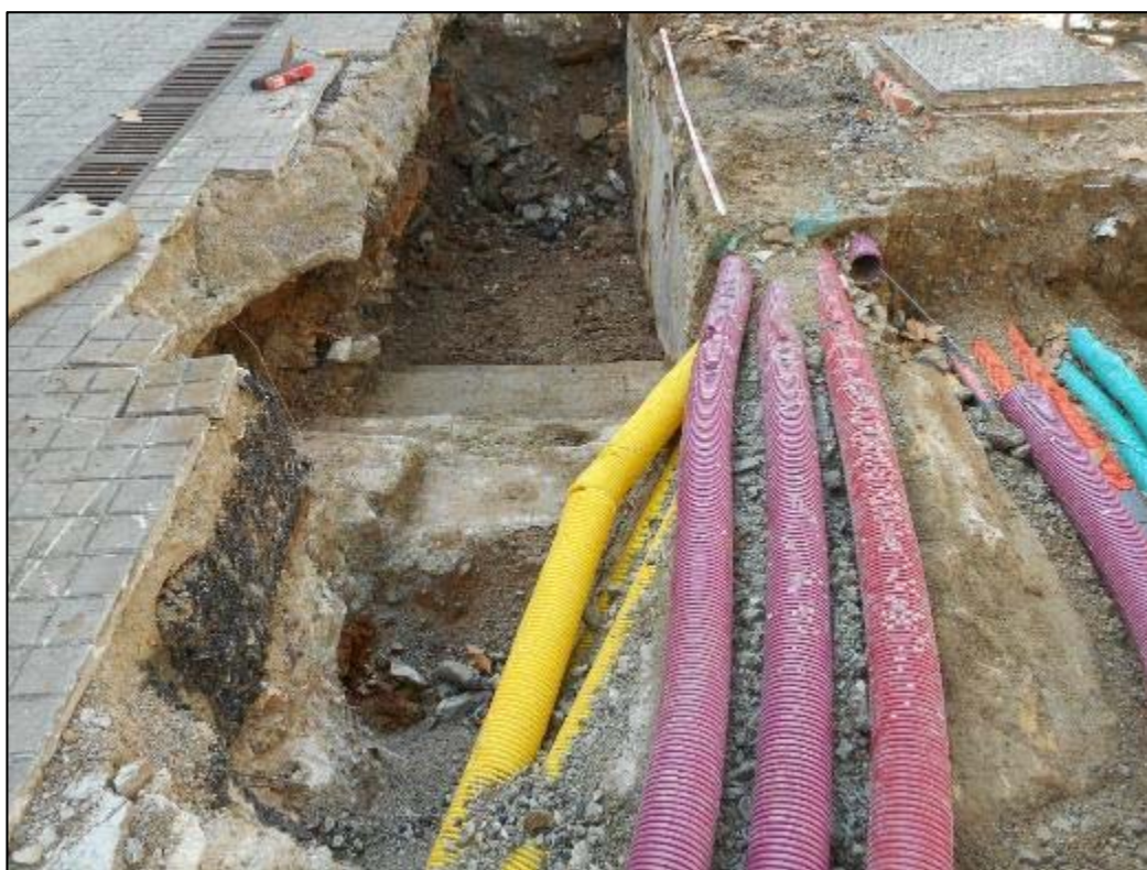
232. Obertura de la rasa a la zona de les escales UE 008 documentades durant les cales inicials.
