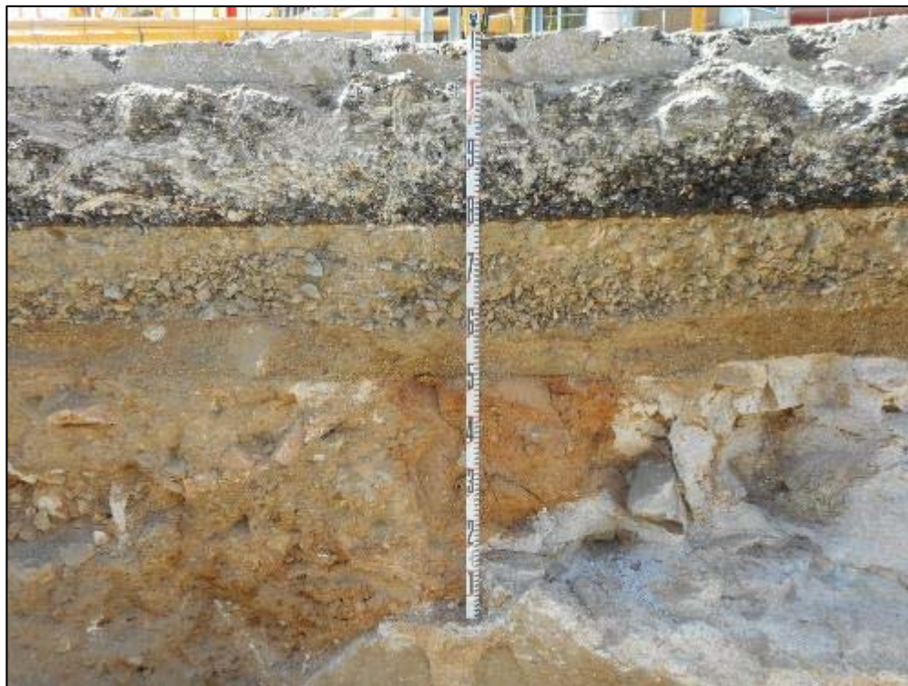
135. Detall de la secció estratigràfica que amortitza l'estructura UE 011 en diferents punts del traçat.
