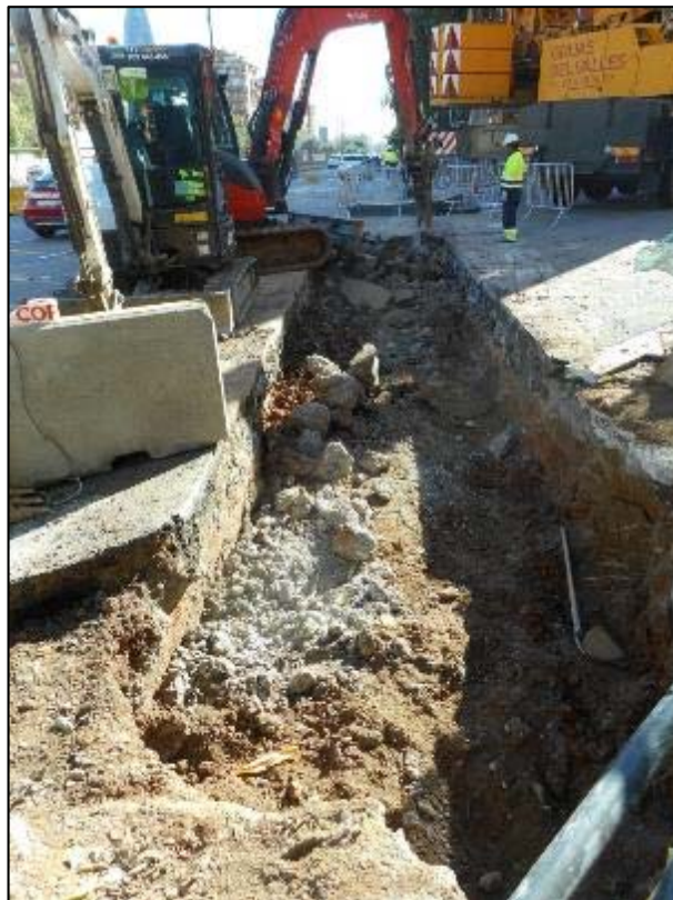
114. Obertura del tram que creua el carrer de València.
