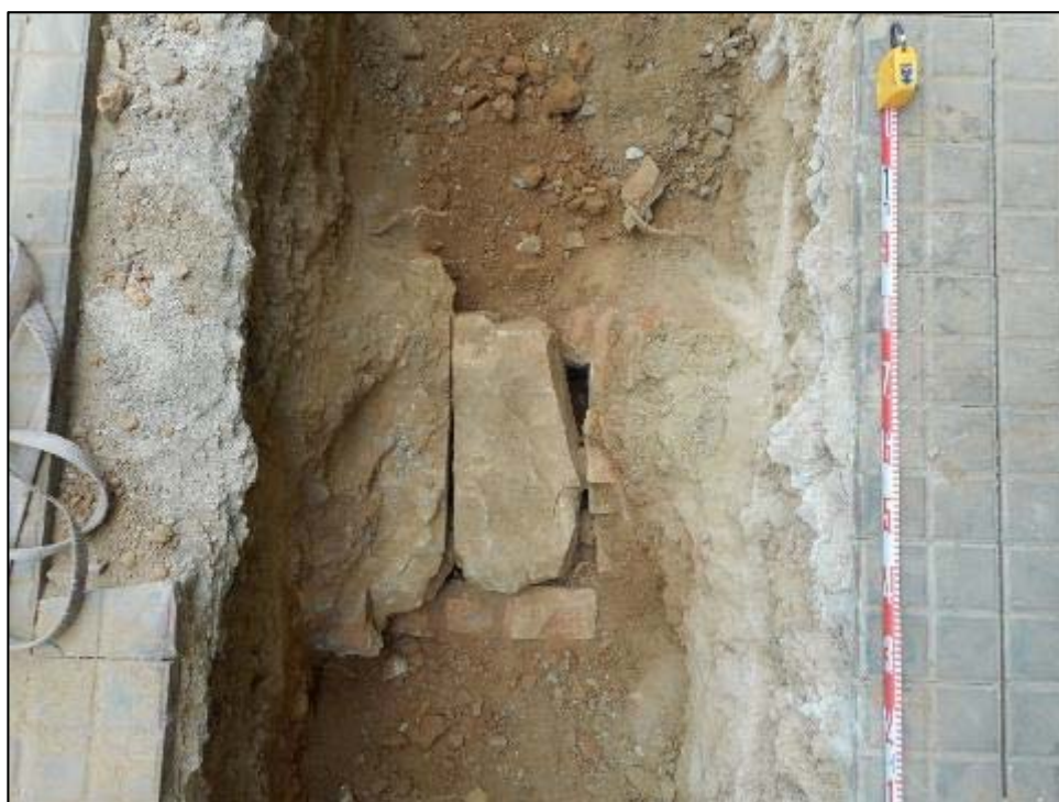
68. Rasa longitudinal, localització de l'antic embornal UE 034.
