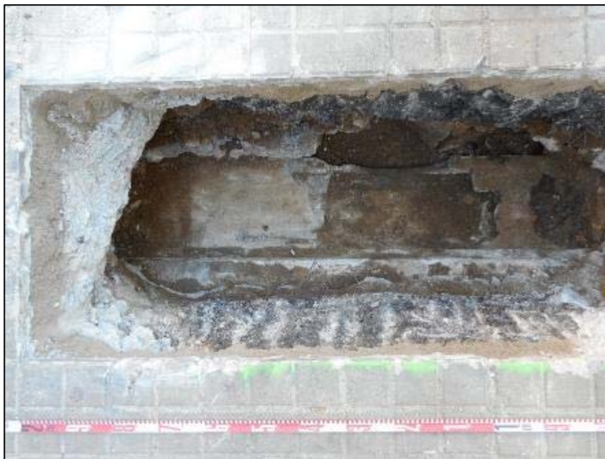
Detall de l'estructura UE 008 dins la Cala 1.
