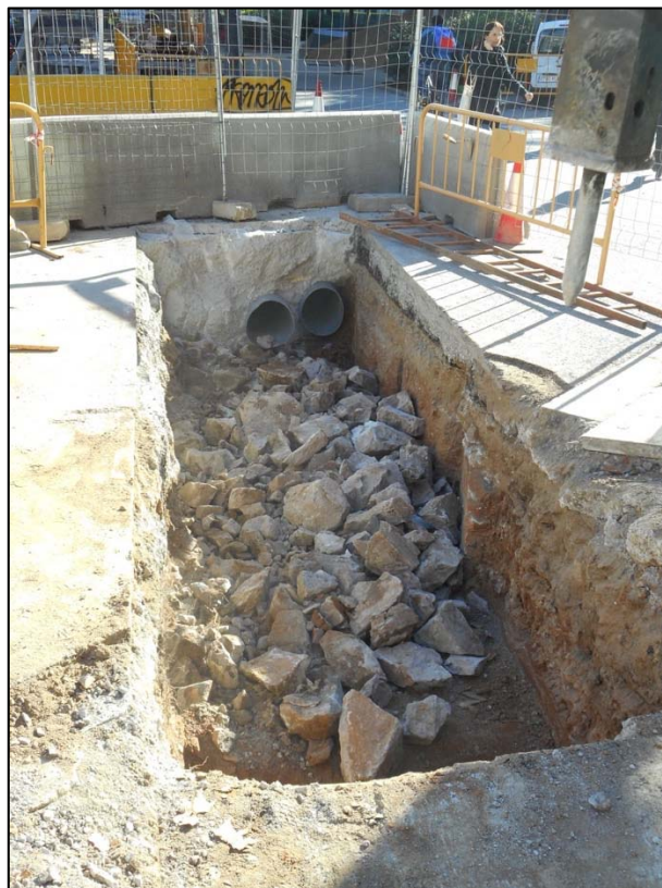
187. Desmuntatge de la prolongació del mur UE 012 al llarg de la rasa de muntanya.
