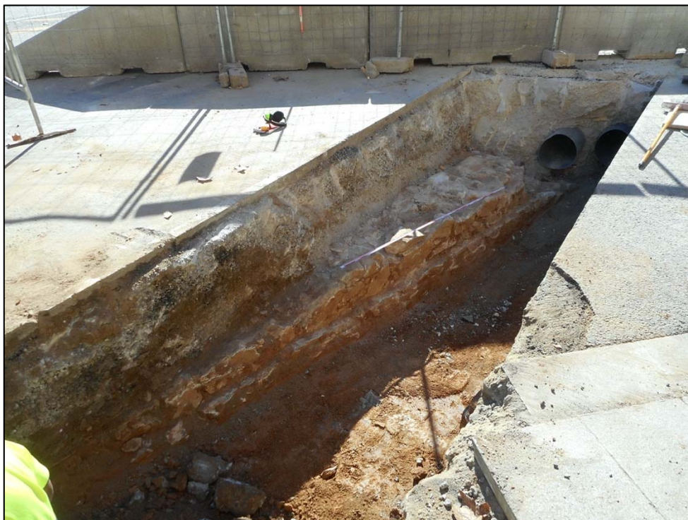
181.Prolongació del mur UE 012 al llarg de la rasa de muntanya.
