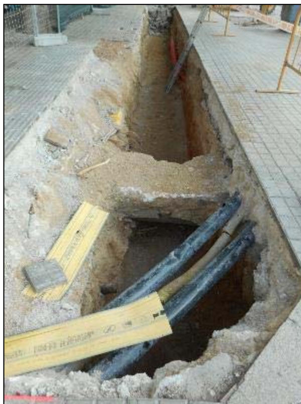
55. Inici de la rasa transversal a la vorera de muntanya.
