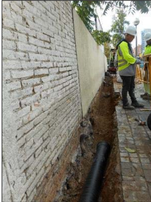
297. Rasa per a la instal·lació de servei d'aigua, en el tram entre els carrers d'Aragó i de València, vorera de mar.
