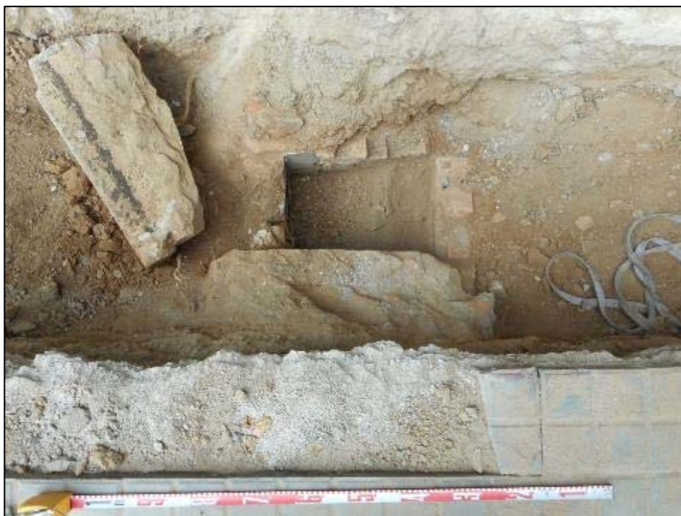
70. Rasa longitudinal, localització de l'antic embornal UE 034, extracció de la coberta de lloses de pedra.
