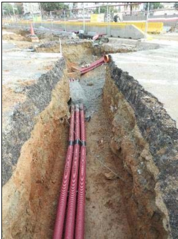
283. Obertura de rasa a la vorera de muntanya, cantonada amb carrer d'Aragó.
