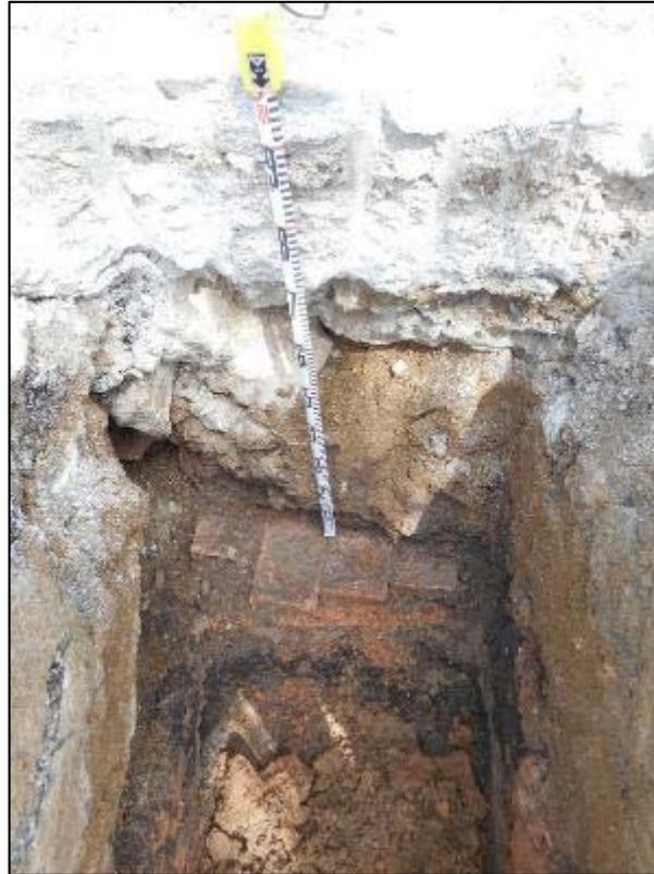
21. Cala 2, presència de maons de protecció de servei elèctric.
