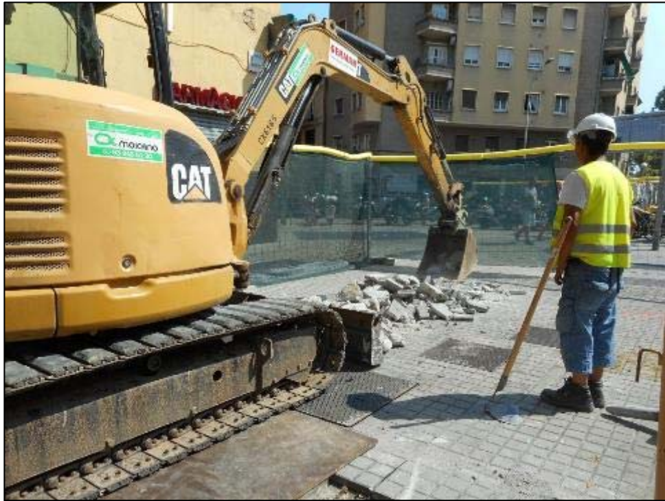
213. Màquina iniciant els treballs de la rasa longitudinal a la vorera de mar.
