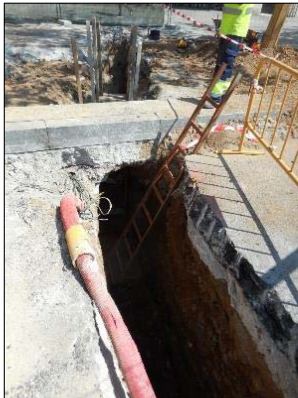
48. Rasa per a instal·lació de tub de connexió a clavegueram existent.
