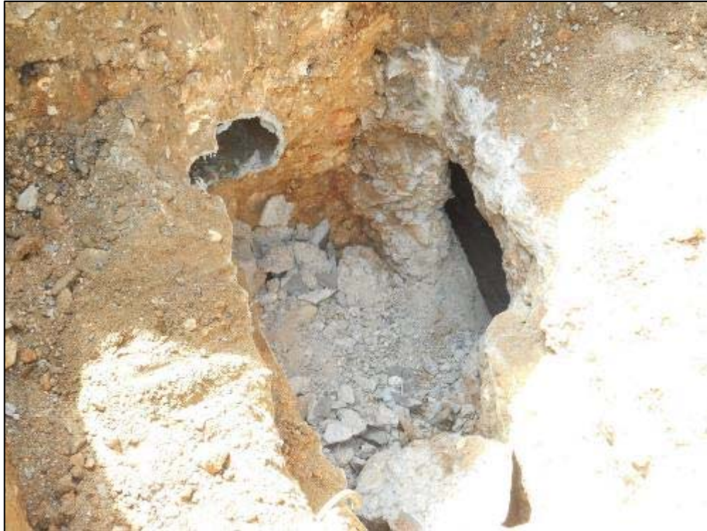
257. Cala 8 desmuntatge sobre col·lector existent, per a col·locar nous embornals.
