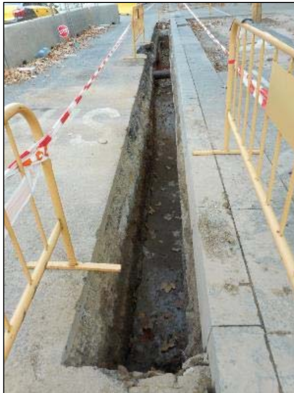
52. Rasa per a substitució del clavegueram anterior, instal·lació de nou servei.
