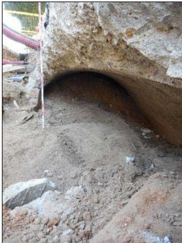
122. Interior de la canalització del Rec Comtal.
