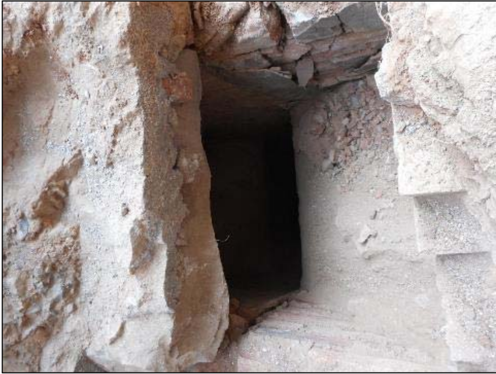
71. Rasa longitudinal, localització de l'antic embornal UE 034, vista de l'interior.
