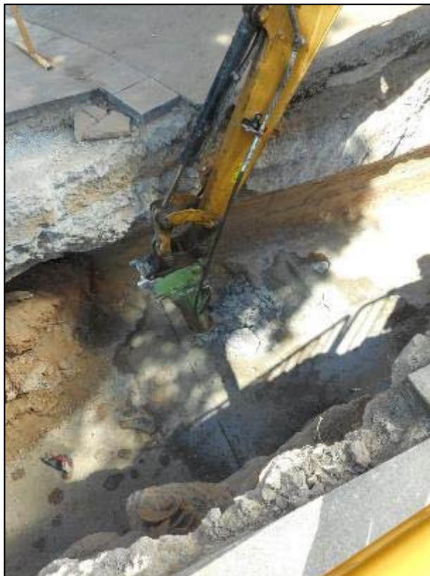
152. Màquina realitzant el desmuntatge de la solera per al sondeig.
