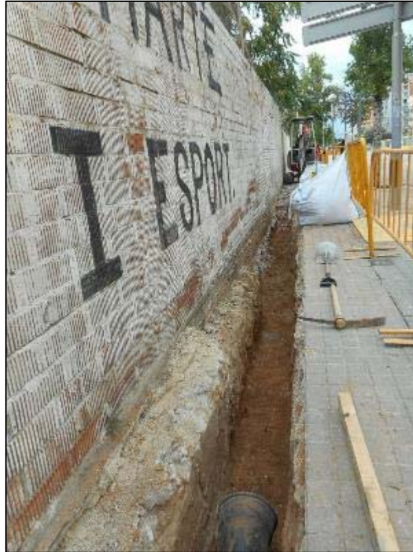
295. Rasa per a la instal·lació de servei d'aigua, en el tram entre els carrers d'Aragó i de València, vorera de mar.
