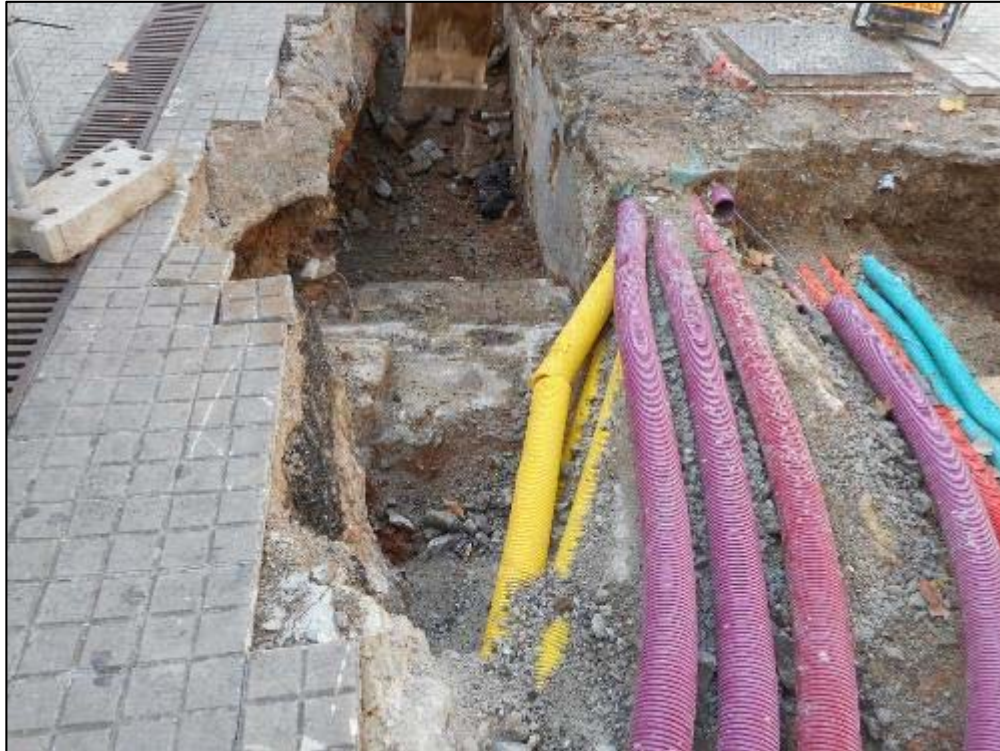
227. Obertura de la rasa a la zona de les escales UE 008 documentades durant les cales inicials.
